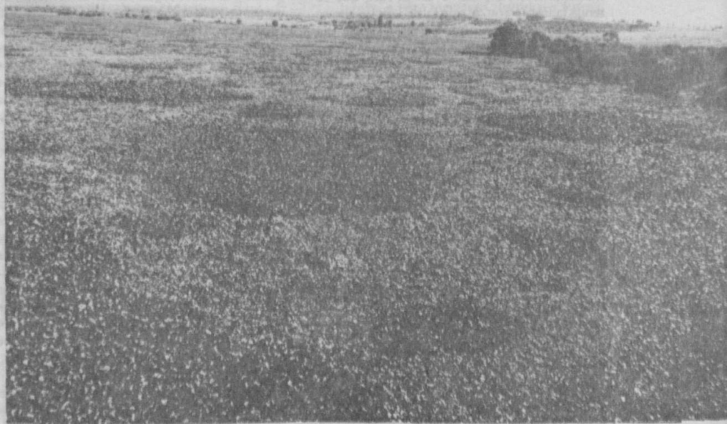
Foto 1 Panorámica de la presa, donde se observa la cubierta de lirio.
